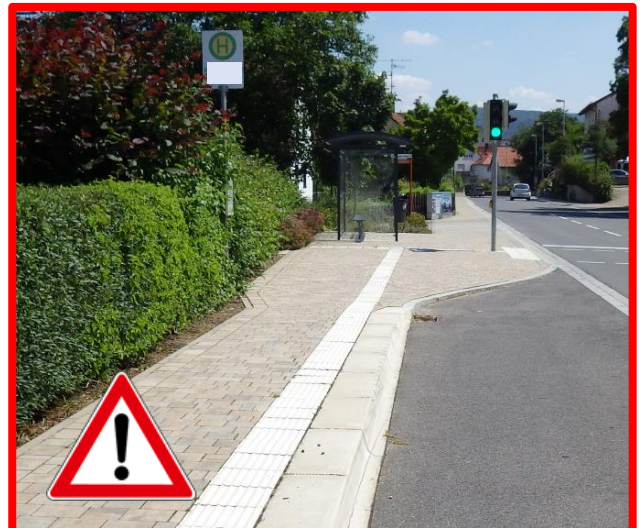
Abb. 28: Der Leitstreifen ist – von der Straßenquerung kommend – gefährlich nah an den Bordsteinrand gebaut worden. Zwischen Bordsteinkante und Leitstreifen muss ein Abstand von mindestens 60 cm vorgehen werden.
